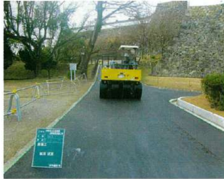
園路舗装の様子
