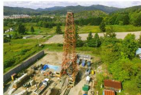
CBM 試掘・生産テスト現場
