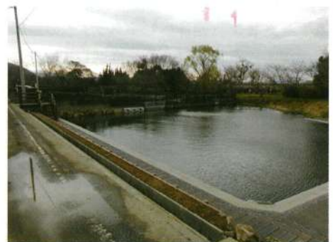
生息地の拡幅や浚渫、魚巣ブロックの設置、観察用デッキの設置を実施したハリヨ池
